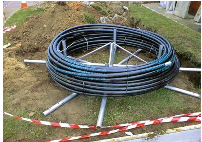
Un dispositivo simple, que facilita el desenrollado de la tubería flexible FLEXWELL-LPG® en el lugar de obra.
